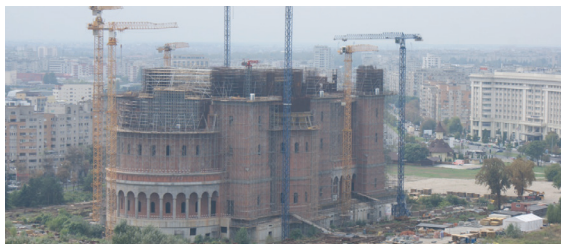
Katedra Zbawienia Narodu Rumuńskiego w budowie.
