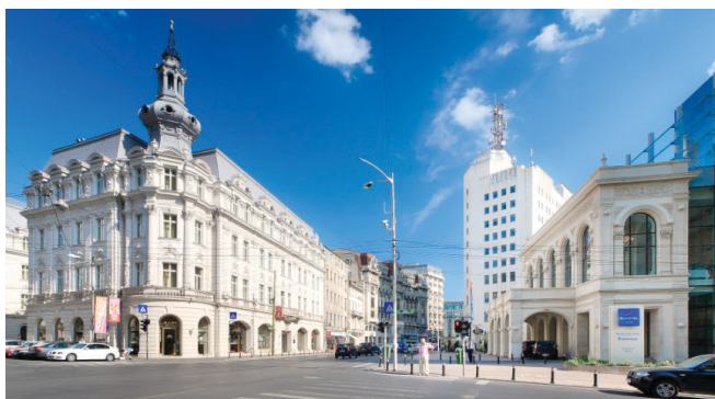
Calea Victoriei, po prawej stronie fasada dawnego Narodowego Teatru Rumunii oraz Pałac Telefonów
