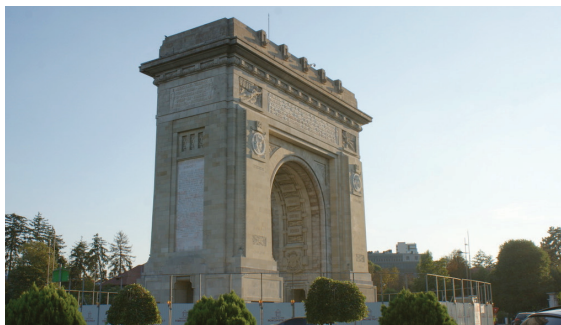
Łuk triumfalny na Șoseaua Kiseleff
